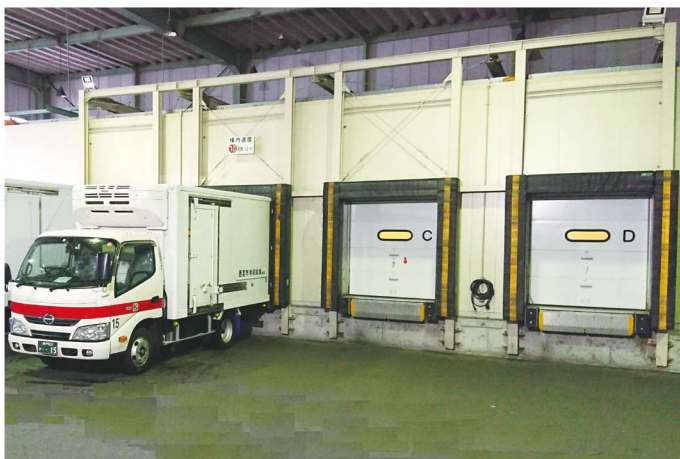
HACCP 対応冷凍冷蔵倉庫
